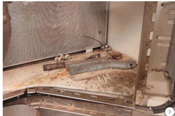
2-Løse gjenstander av metall ligger i rom med vanntette dører, i verste fall kan disse komme i klem mellom døren og karmen
