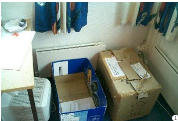
1-Brennbart materiale plassert inntil en elektrisk varmeovn. Tenk at det kan begynne å brenne her.
