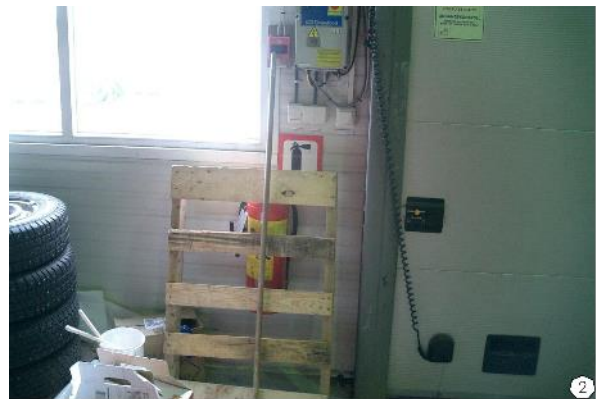
2-Brannslukkingsapparat er ikke lett tilgjengelig, dette kan tillate at hendelsen eskaleres ytterligere
